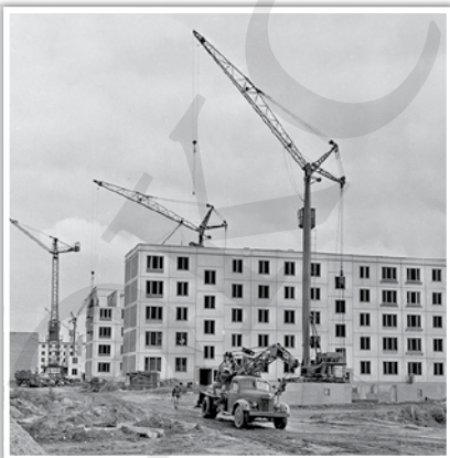
Строительство жилых домов в новом районе Мнёвники. Москва. 1959 г.
